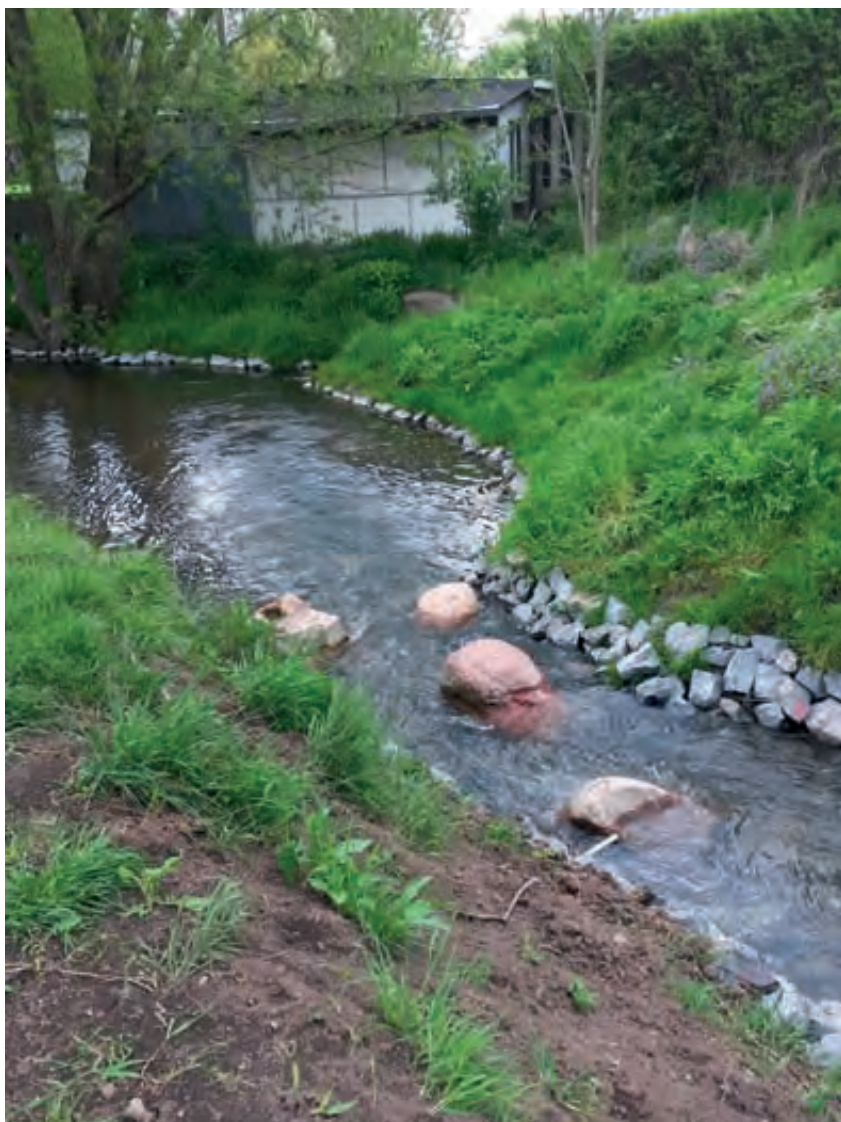
Die Sohlgleite an der Pfeffermühle Halberstadt vor der Fertigstellung Foto: UHV Ilse Holtemme
