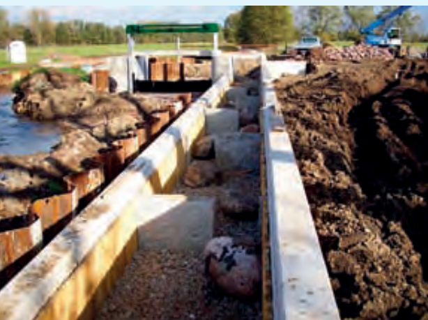
Der Fischpass mit Steinschüttungen vor der Fertigstellung Foto: Planungsbüro Pretzier
