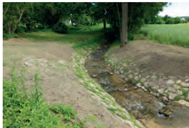
Die neue Sohlgleite für den Steinbach ist 2014 fertig. Foto: UHV Untere Unstrut
