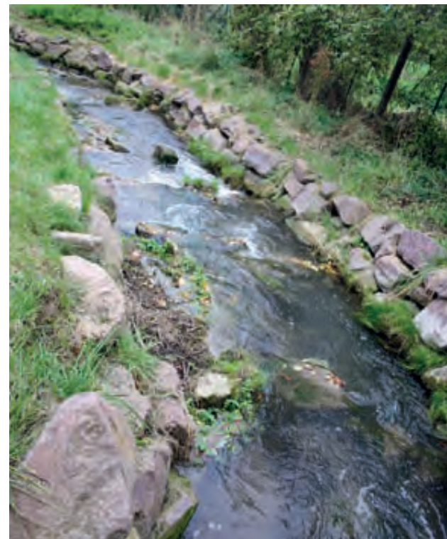
Dank der geschwungenen Sohlgleite ist die Laweke in Zappendorf ökologisch durchgängig, große Steine dienen als Uferbefestigung Foto: S. Reh
