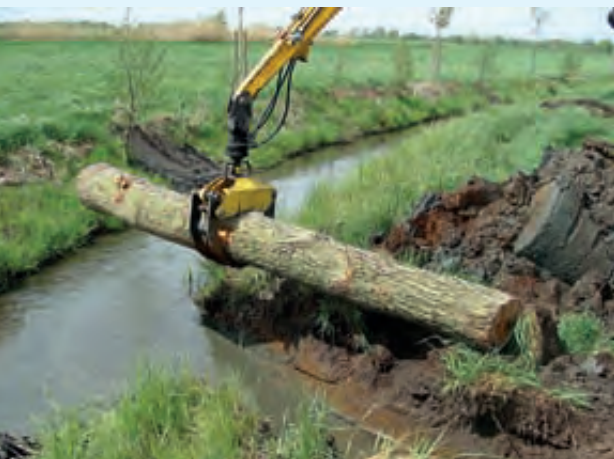
Totholzeinbau am neuen Lauf der Ehle Foto: Ehle-Ihle Verband
