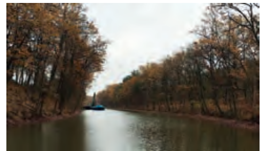
Der dritte Bauabschnitt ist kurz vor der Fertigstellung Foto: M. Kühnast
