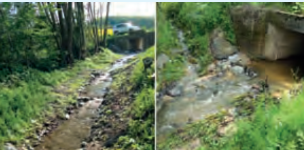
Der Gutschbach bei Steinbach im Mai 2012 und der neue Durchlass in Steinbach im Juni 2013 Fotos: UHV Untere Unstrut
