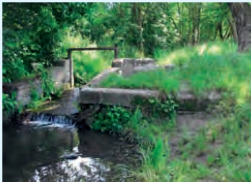
Die alte Stauanlage Pfeffermühle in Halberstadt war für Wasserlebewesen nicht passierbar Foto: UHV Ilse Holtemme
