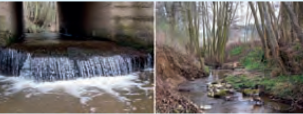
Der alte Durchlass mit Absturz für den Gutschbach bei Steinbach und der Zustand vor der Realisierung Fotos: UHV Untere Unstrut
