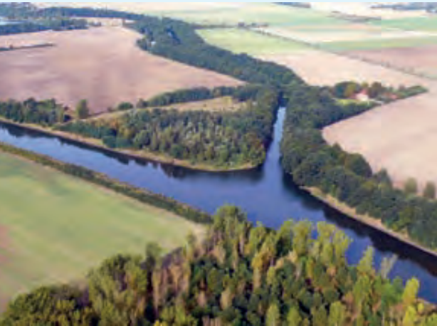
Luftaufnahme vom ersten Bauabschnitt der Entschlammung des Altkanals bei Niegripp Foto: Ehle-Ihle Verband
