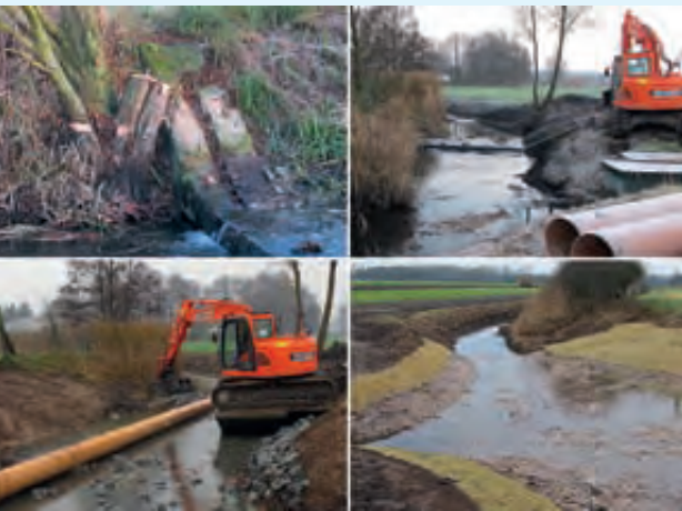
Eine der drei alten Stauanlagen, die im Sollnitzbach als ökologische Barriere wirken (oben links); Im November 2014 beginnt die Beseitigung der Stauanlagen (oben rechts); Die Ufer des neuen Bachbettes werden mit Steinschüttungen stabilisiert (unten links); Das neugeformte Bett des Sollnitzbaches (unten rechts), Fotos: UHV Mulde
