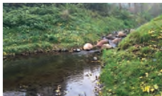
Der Kolk nach dem früheren Wehr wurde erhalten und mit Wasserbausteinen gesichert, Foto: M. Kühnast
