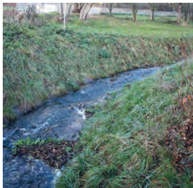
Die neue, leicht geschwungene Sohlgleite für den Steinbach in Bad Bibra, Foto: S. Reh
