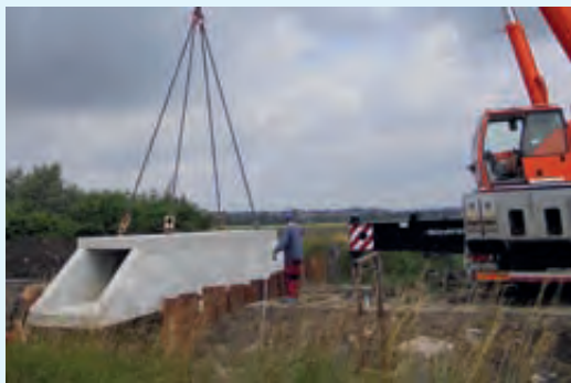
Die Elemente für den neuen Durchlass werden angeliefert, Foto: UHV Ilse Holtemme
