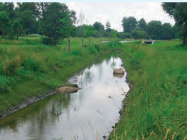
Der neue Ehle-Lauf mit Störsteinen und neu angepflanzten Bäumen, Foto: Ehle-Ihle Verband
