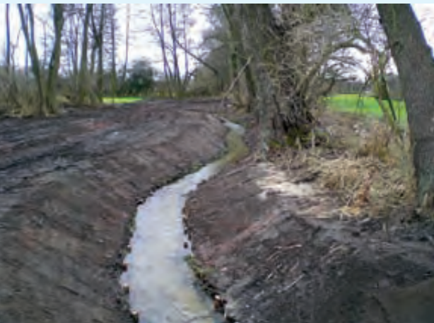
Der neue Lauf des Bomsdorfer Grabens kurz nach der Fertigstellung, Foto: Ehle-Ihle Verband
