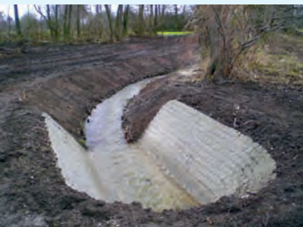
Neuer Durchlass unter einem Wirtschaftsweg Foto: Ehle-Ihle Verband
