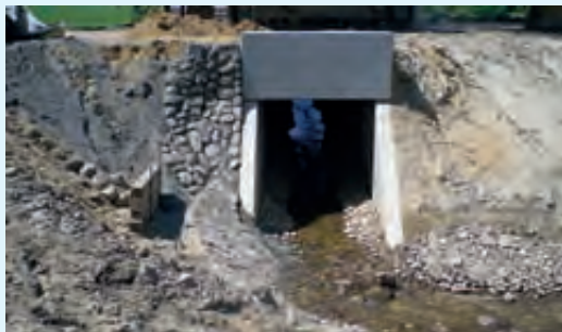
Der neue Straßendurchlass für den Molmker Bach nimmt Gestalt an, Foto: UHV Jeetze
