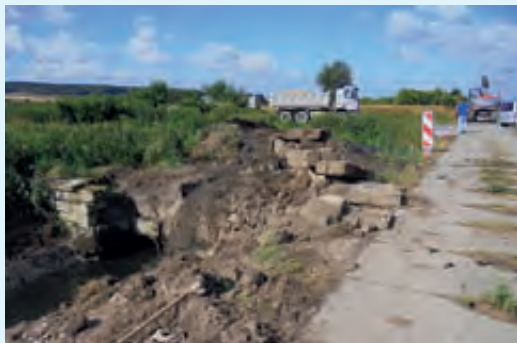
Die alte Stauanlage wird abgerissen Foto: UHV Ilse Holtemme
