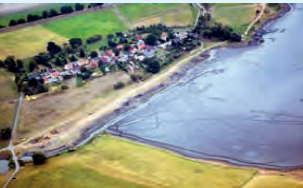
Luftbild der Baustelle an der Alten Elbe bei Lostau Foto: Ehle-Ihle Verband
