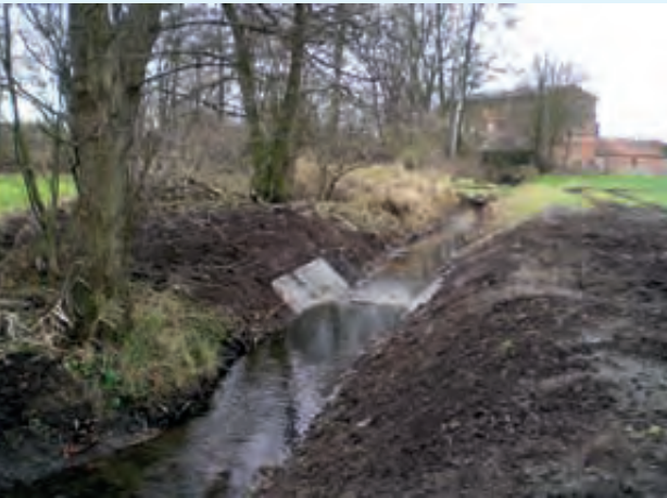
Der alte begradigte Lauf des Bomsdorfer Grabens wurde ebenfalls saniert, Foto: Ehle-Ihle Verband
