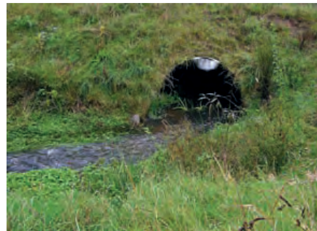
Der neue Durchlass an der Stelle der früheren Stauanlage an der ehemaligen Papierfabrik Foto: M. Kühnast
