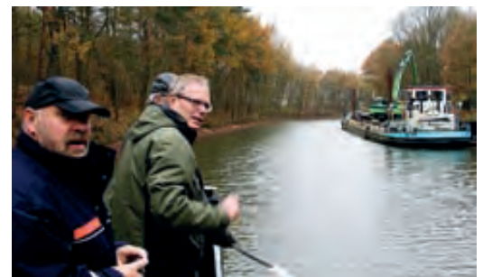
Baubesprechung im November 2015 kurz vor Fertigstellung des dritten Bauabschnitts Foto: M. Kühnast
