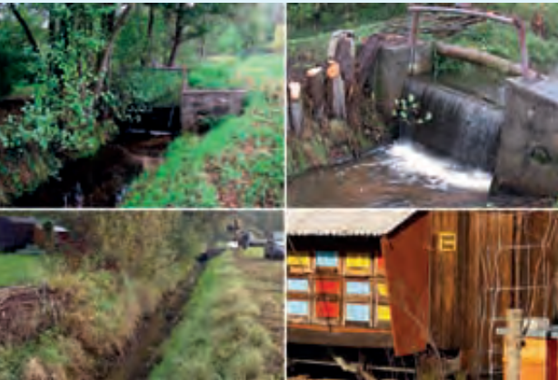
Der Stau Rotta war eine ökologische Barriere im Kemberger Flieth (oben links); Der etwa ein Meter hohe Absturz war für Wasserlebewesen unüberwindbar (oben rechts); Der Rückbau des Staus bei Rotta beginnt (unten links), Fotos: UHV Fläming; Beim Rückbau des Staus Rotta hieß es: „Vorsicht Bienen!“ (unten rechts), Foto: S. Reh
