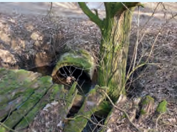
Alter Gloine-Durchlass nahe der Az Foto: UHV Stremme
