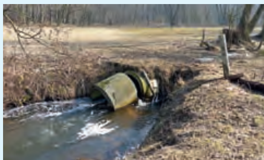
In die Jahre gekommener Rohrdurchlass unweit der A2, den der UHV 2012 erneuert hat. Foto: UHV Stremme/Fiener Bruch
