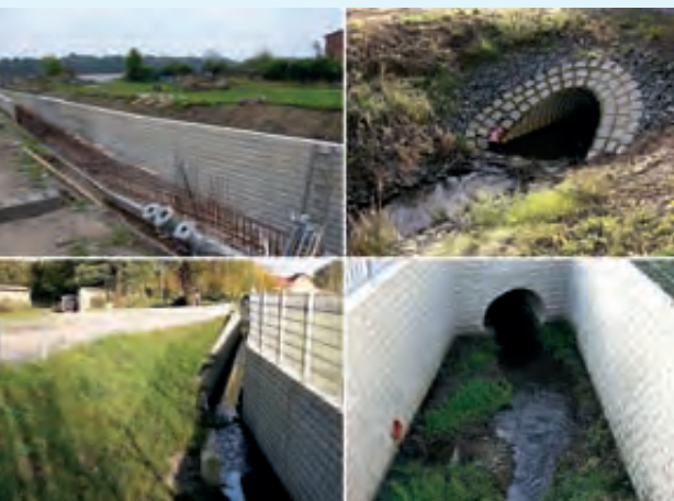
Die Stützmauern des neuen Grabenbettes nehmen die Mauerwerksstruktur der umliegenden Gebäude auf (oben links); Foto: UHV Aller; Neuer Straßendurchlass für den Johannisteichgraben (oben rechts); Trotz des geringen Platzes kann der Johannisteichgraben dank der Stützmauern wieder offen durch Morsleben fließen (unten links); Wasserpflanzen ergreifen allmählich Besitz von dem neuen, offenen Grabenlauf; Fotos: M. Kühnast
