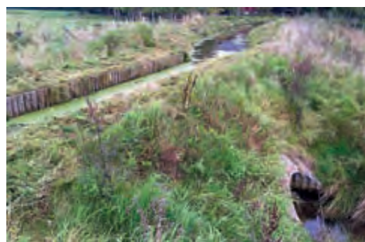
Das kleine „Wasserstraßenkreuz“: Das neue Bett der Uchte führt unter ihrem alten - dem Triebwerksgraben - hindurch, Foto: M. Kühnast
