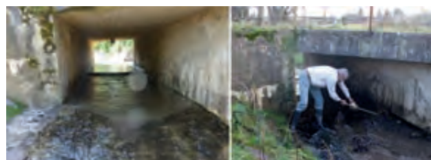
Der neue, helle Durchlass für den Steinbach, der für Wasserorganismen kein Hindernis mehr ist; Der Geschäftsführer des UHV Untere Unstrut, Günter Höroldt, im Einsatz Fotos: S. Reh
