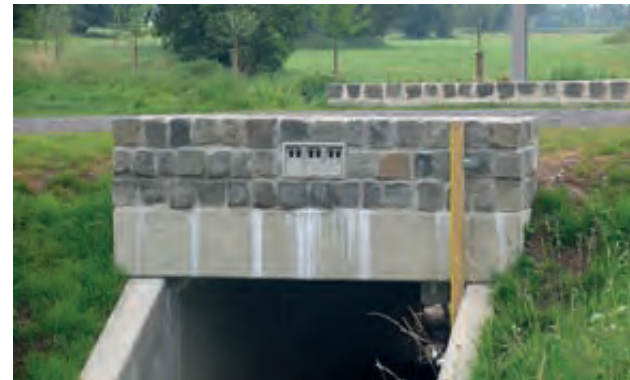
Der neue Durchlass für den alten, begradigten Lauf der Ehle, Foto: Ehle-Ihle Verband
