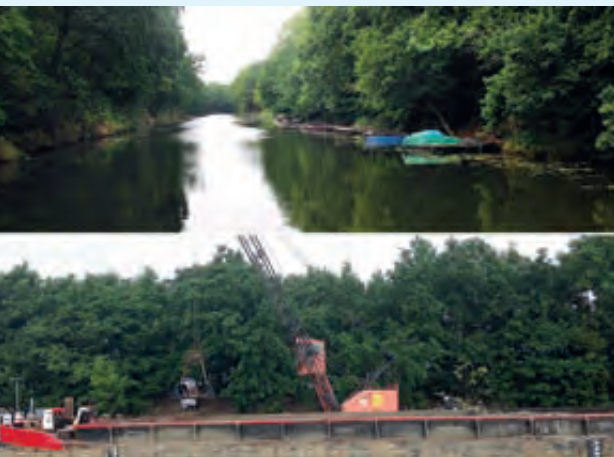
Der Altkanal bei Niegripp: eine Idylle für Angler, Paddler Sportboot-Kapitäne; Der Abtransport von Schlamm erfolgte ebenso per Schiff wie das Heranschaffen der Steine für die Uferbefestigung; Fotos: Ehle-Ihle Verband
