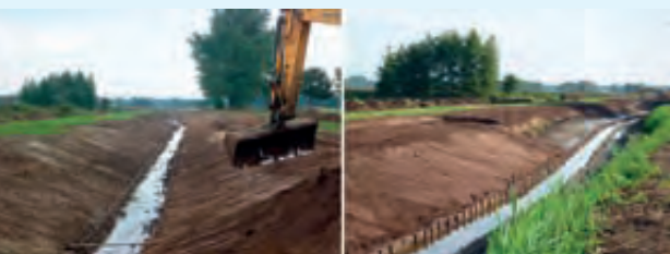
Ausformung der neuen flacheren Böschungen Die Einengung der Sohle durch Faschinensicherung verbessert das Fließverhalten Fotos: IHU Geologie und Analytik GmbH Stendal
