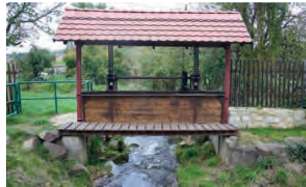
Die sanierte Wehranlage an der Laweke in Zappendorf Foto: S. Reh
