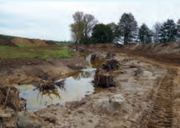
Totholzteinbau an der neuen Uchte-Schleife bei Deetz Foto: UHV Uchte
