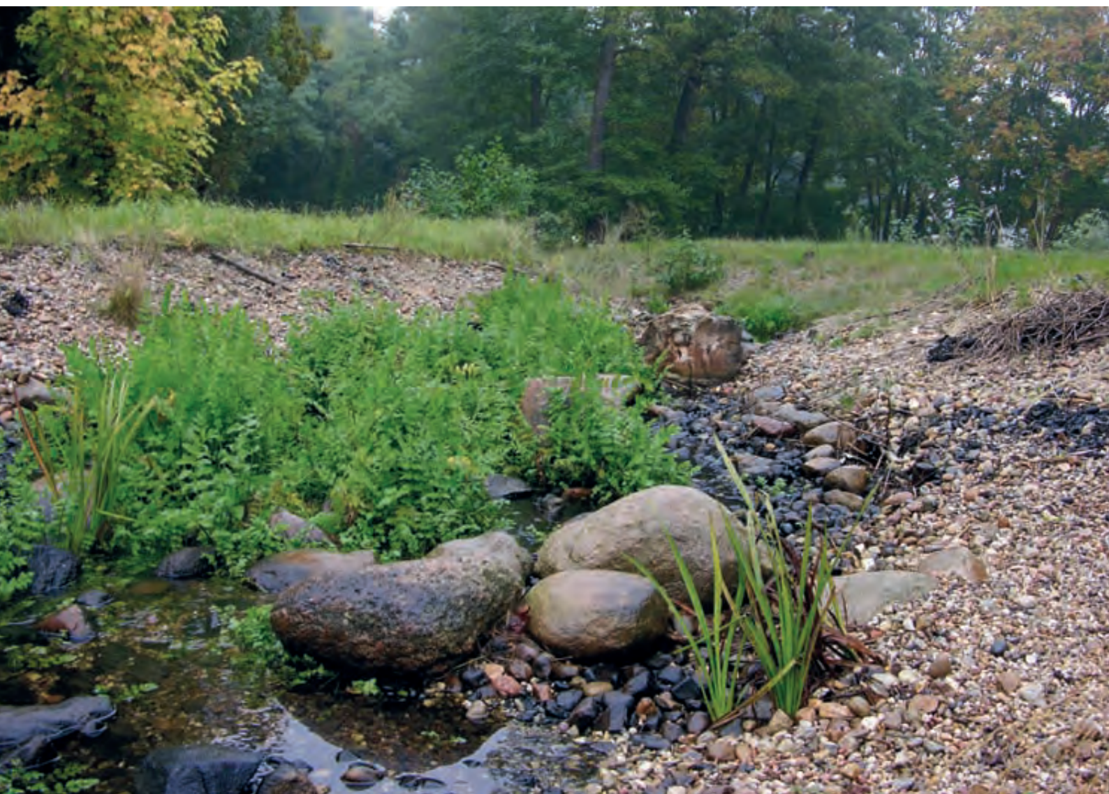
Die neue Sohlgleite der Gloine in Dörnitz Foto: M. Kühnast
