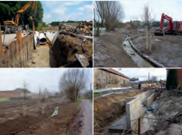
Bau des neuen Straßendurchlasses und des neuen Bettes (oben beide) Baumpflanzungen am neuen Grabenverlauf (unten links) Bau des offenen Grabenverlaufs unter dem Fußweg in Morsleben (unten rechts; Fotos: UHV Aller
