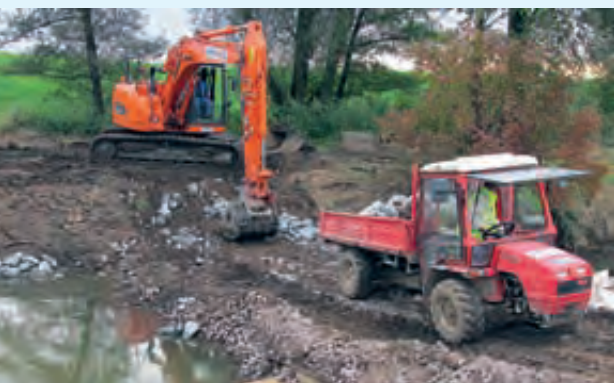
Steine für das neue Bachbett werden angeliefert Foto: UHV Mulde
