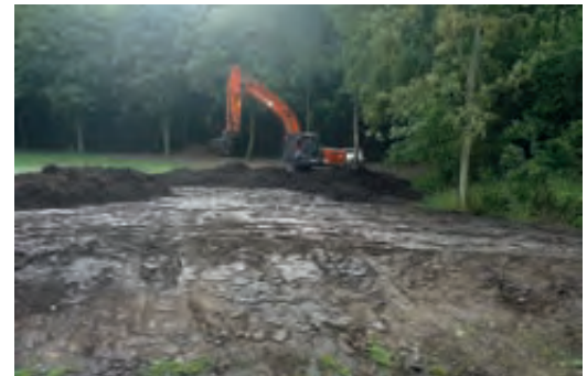
Bauarbeiten am neuen Bett der Sarre Foto: UHV Untere Bode
