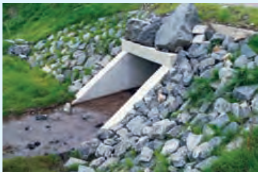
Der neue Durchlass unter dem Wirtschaftsweg ist fertig Foto: UHV Ilse Holtemme
