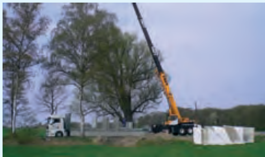
Die Bauteile für den neuen Durchlass werden geliefert Foto: UHV Jeetze
