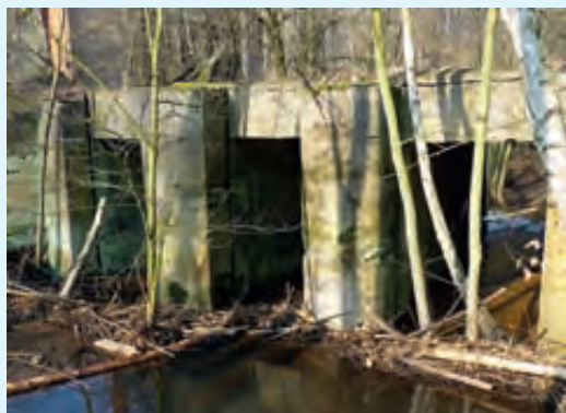
Alte Stauanlage an der ehemaligen Papierfabrik bei Magdeburgerforth Foto: UHV Stremme/Fiener Bruch
