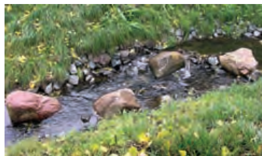
Die Böschungsfüße sind mit Wasserbausteinen gesichert worden, Foto: M. Kühnast
