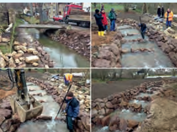
Arbeiten zur Herstellung der ökologischen Durchgängigkeit der Laweke in Zappendorf (oben links); Die Becken der Sohlgleite werden geformt (oben rechts); Die Steine zur Uferbefestigung werden eingebracht (unten links); Nach der Fertigstellung der Fischaufstiegsanlage ist die Beckenstruktur gut zu erkennen (unten rechts).
