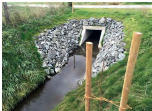
Der neue Durchlass mit einem neu gepflanzten jungen Baum, Foto: M. Kühnast
