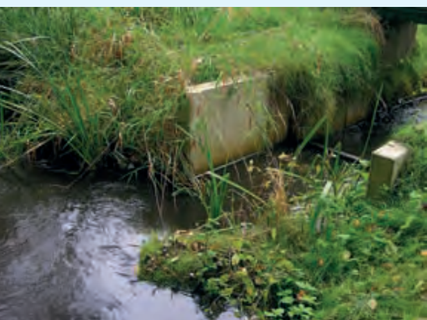
Der Zulauf zur neuen Sohlgleite, die um das Wehr herumführt Foto: M. Kühnast
