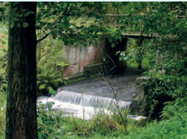
Das Wehr mit dem 70 Zentimeter hohen Absturz an der früheren Wassermühle Domröse Foto: M. Kühnast
