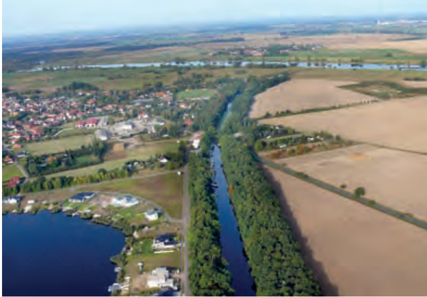
Luftaufnahme vom dritten Bauabschnitt Foto: Ehle-Ihle Verband
