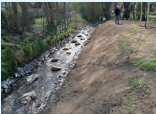
Die alte Stauanlage an der Pfeffermühle in Halberstadt wird durch eine Sohlgleite ersetzt Foto: UHV Ilse Holtemme
