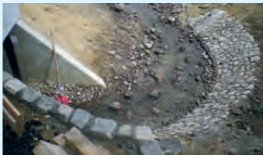
Das Bachbett am Durchlass wird neu geformt Foto: UHV Jeetze
