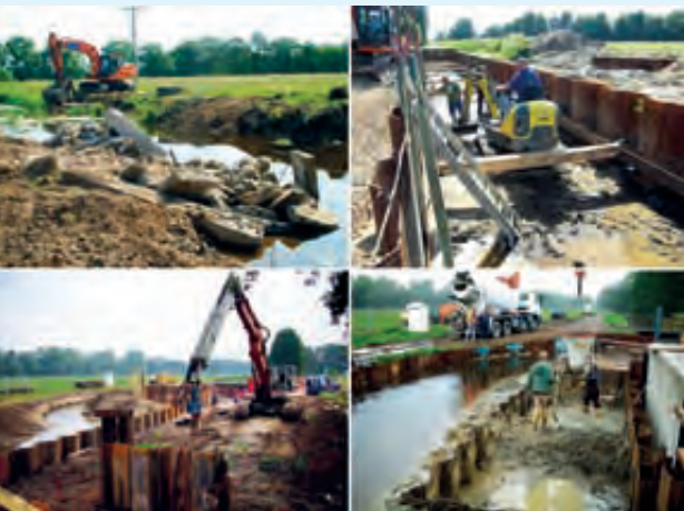
Mit Abbruchhammer zerlegte alte Stauanlage Bodenaushub und Rammarbeiten am Fischpass Betoneinbau der Flügelwände des nördlichen Widerlagers Fotos: Planungsbüro Pretzier
