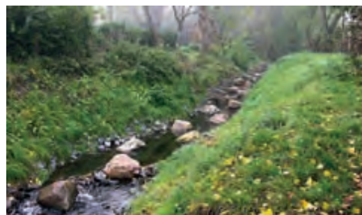
Störsteine sorgen für eine gute Gewässerdynamik im Goldbach, Foto: M. Kühnast
