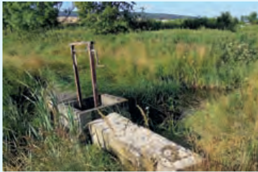
Die in die Jahre gekommene alte Stauanlage am Steinbach, Foto: UHV Ilse Holtemme
