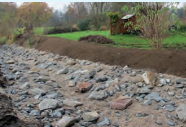
Die neue Sohlgleite des Kemberger Flieths wird geformt Foto: UHV Fläming
