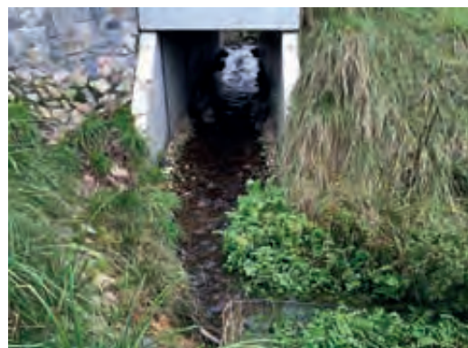
Durch den neuen Durchlass hat der Molmker Bach eine bessere Gewässerdynamik bekommen, Foto: M. Kühnast
