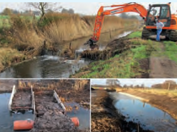
Beginn der Arbeiten an der zweiten Stauanlage (oben); Künstliche Sperre während der Bauarbeiten im Bereich einer ehemaligen Stauanlage (unten links); Das neue, ökologisch durchgängige Bett des Sollnitzbaches (unten rechts), Fotos: UHV Mulde
