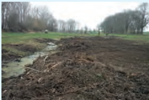
Der alte Gewässerlauf wird wieder hergestellt Foto: UHV Untere Bode
