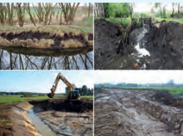
Am Triebwerksgraben kam es immer wieder zu Abbrüchen der Böschungen (oben links); Der Triebwerksgraben vor der Realisierung des WRRL-Projekts (oben rechts); Bei Deetz erhält die Uchte einen neuen naturnahen Lauf. Es ist das Ersatzprojekt für die 1.000 am Triebwerksgraben gefälltten Bäume und Büsche (unten links); Der Triebwerksgraben wird neu gestaltet (unten rechts) Fotos: UHV Uchte
