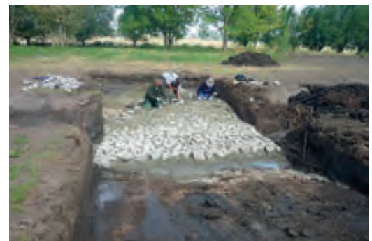
Arbeiten an der Furt durch das neugestaltete Gewässerbett, Foto: UHV Untere Bode
