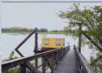
Abb. 7: Elbe bei Magdeburg, linkes Ufer - Automatische Messstation
