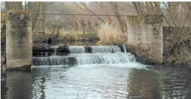
Wehr an der Wipper vor Umbau
